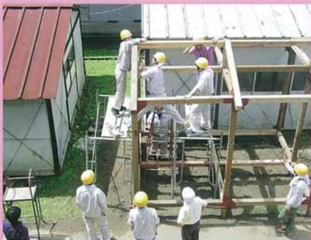
市川工業高校建築科の生徒による災害時の 廃材利用を想定した被災者用仮設住宅の建設実験
