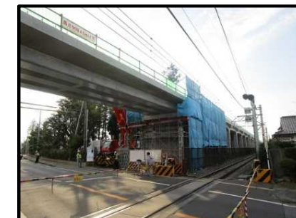
④高架橋工事(第170号踏切北側)
