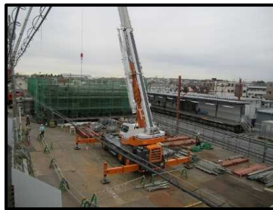
②高架橋工事(愛宕駅)
