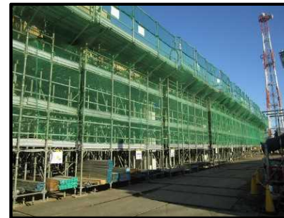
③高架橋工事(野田市駅)
