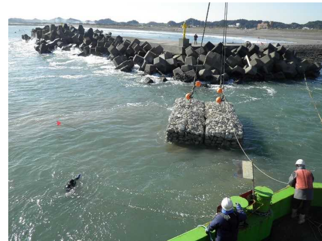
5号ヘッドランド 海上施工
