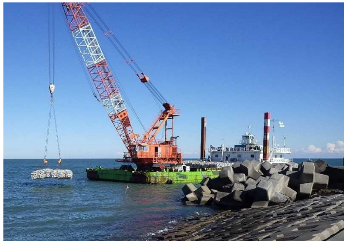
5号ヘッドランド 海上施工
