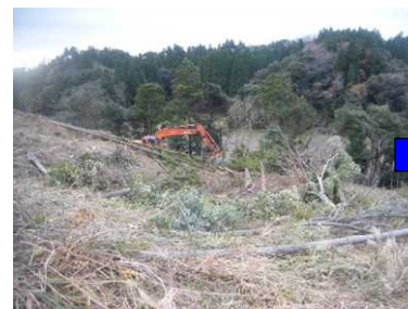
造成工事により木材が発生
