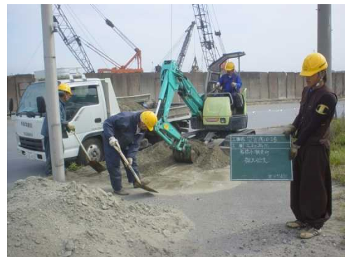
土砂撤去 (葛南港湾事務所)
