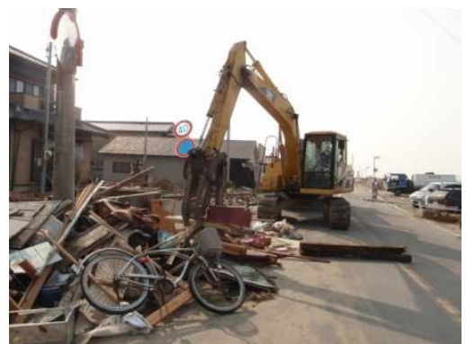
（主）飯岡一宮線 倒壊物撤去
