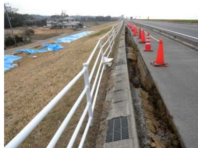
(国)356号 法面崩壊による路面亀裂
