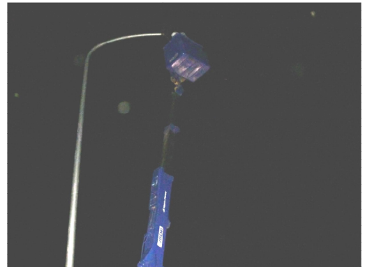
（一） 松戸三郷線 照明灯灯具撤去
