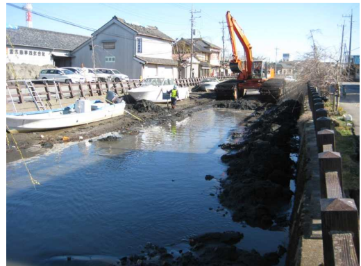
（一）小野川 河道掘削
