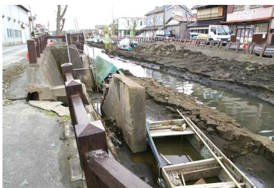
液状化と側方流動による噴砂と護岸倒壊・小野川(香取市)
