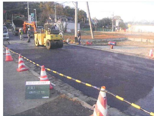
（一）白井流山線 舗装工
