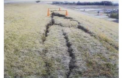
(国)356号 法面崩壊による路面亀裂
