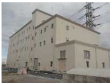
①汚泥処理棟全景
