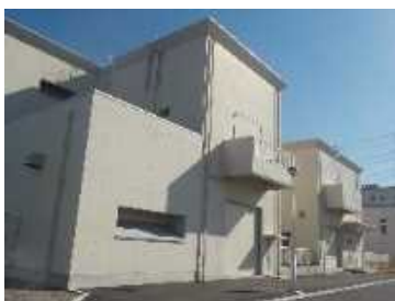
②主ポンプ棟全景
