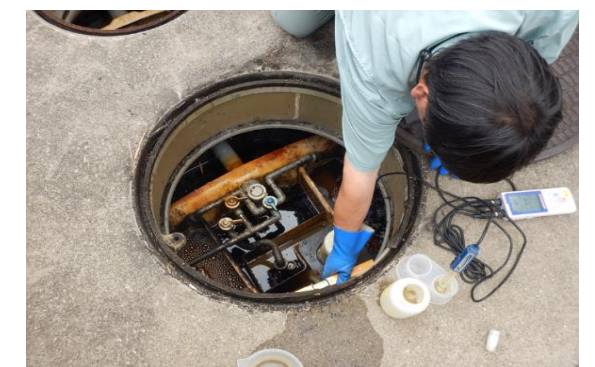
合併処理浄化槽の検査状況
