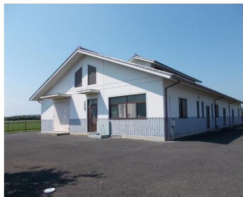
東金市 上谷クリーンセンター （農業集落排水）
