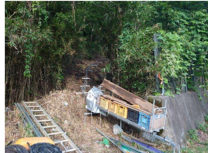
モノレール設置状況
